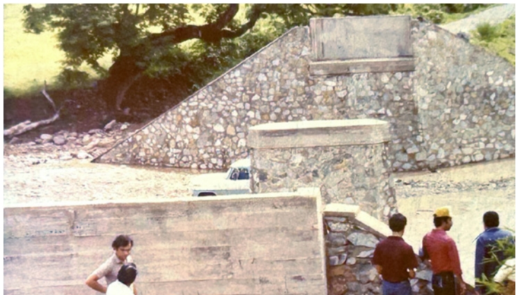
En el puente El Zopilote, en la sierra entre Nayarit y Zacatecas, con ingenieros de la SAHOP.
