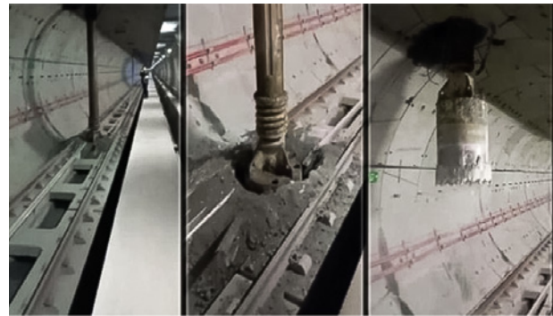
Figura 3. Perforación de un túnel en Estambul (Akbar, 2024).
