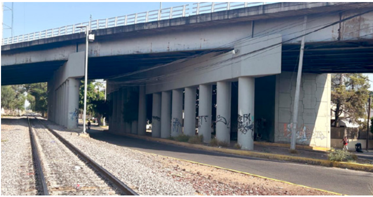
Puente de la Av. Vallarta sobre las vías del ferrocarril. Este fue el primer puente con estribos de muros con tierra armada en Guadalajara. José Francisco de la Mora trabajó en su cimentación y fue residente de la obra desde el inicio hasta su inauguración, hace 40 años.
