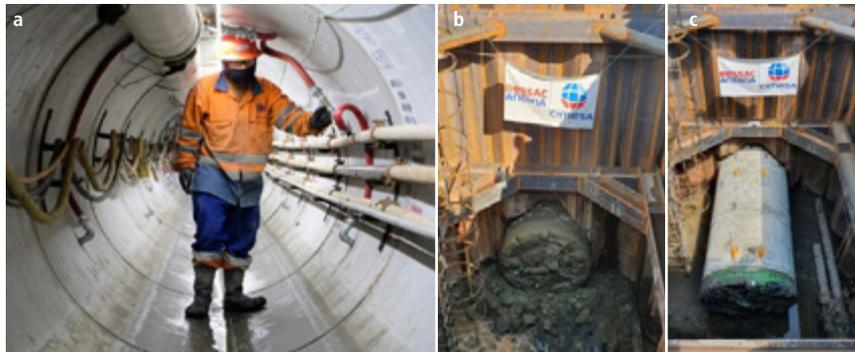
Figura 19 a) Vista interior del microtúnel; b) vista de la rueda de corte a través de la tablestaca metálica; c) salida de la microtuneladora a la lumbrera de llegada.
