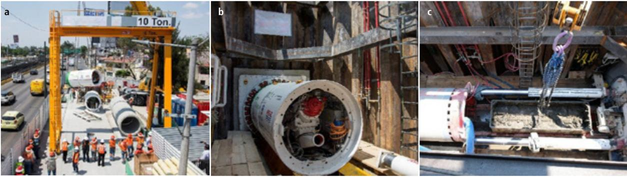
Figura 18. a) Maniobra de montaje de microtuneladora en lumbrera de lanzado a un costado de la lateral del Circuito Interior; b) posición de la microtuneladora en lumbrera de lanzado después del corte de la tablestaca metálica; c) posición de la microtuneladora, gatos para empuje de tubería de concreto y sistema de rezaga de material.
